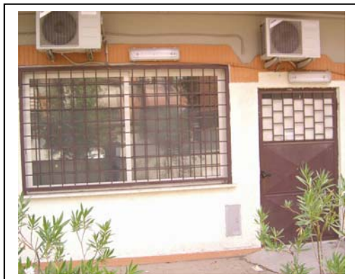
Foto n. 30 – Ufficio dei Vigili Urbani
